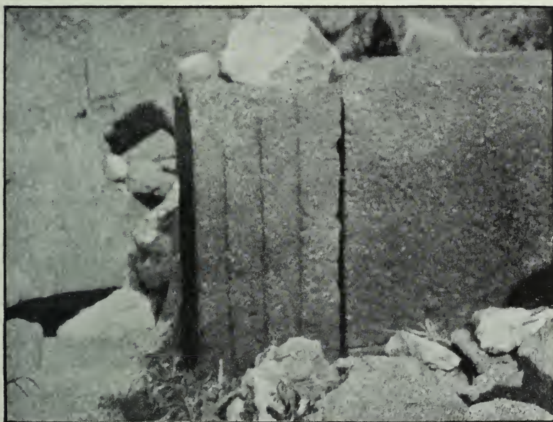
FIG. 78.—No. 11, W. door jamb.
